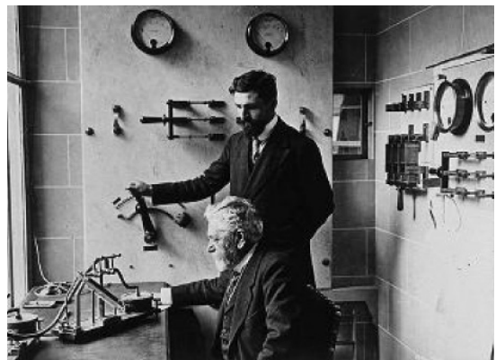
写真13 まだ現役だった頃の制御室 2) 手前がエッフェル
