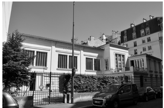
写真3 エッフェル空力研究所 西側から
